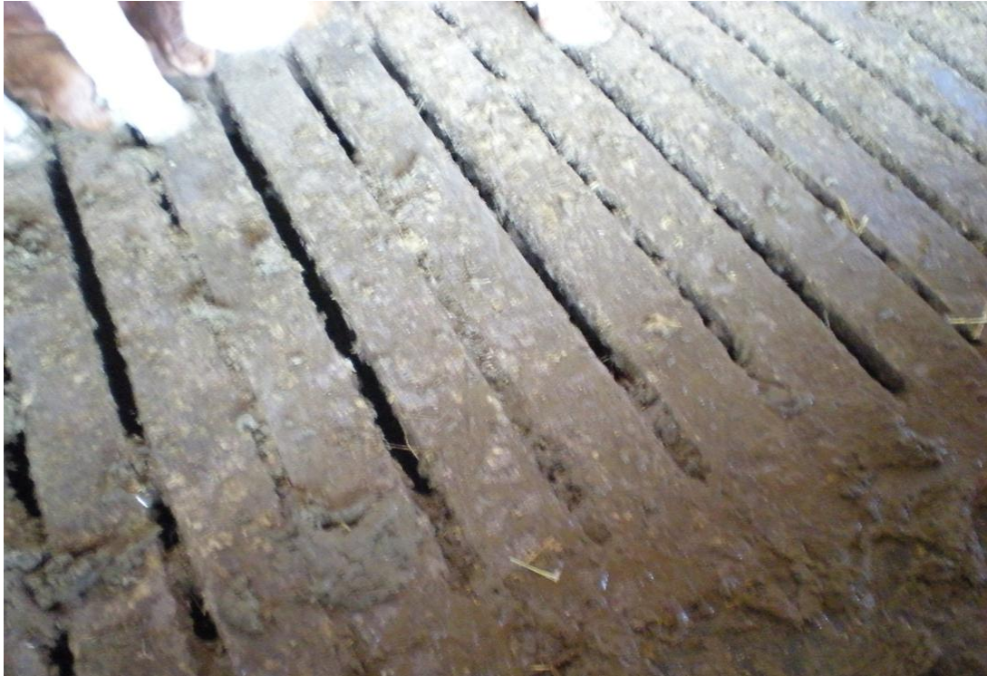
Figura 12 – Esempio di pavimento fessurato non rivestito in gomma.
